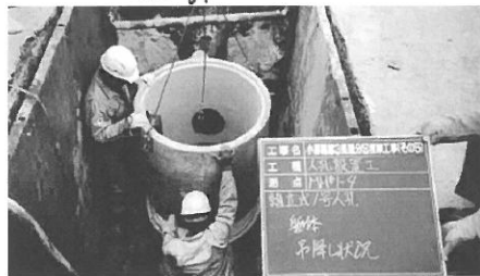
下水道工事のもよう
