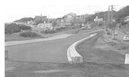
工事が進む新県道29号線
