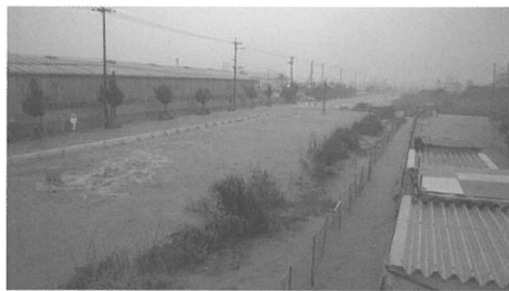
急激な大雨により氾濫した小波津川 (平成25年5月23日)
