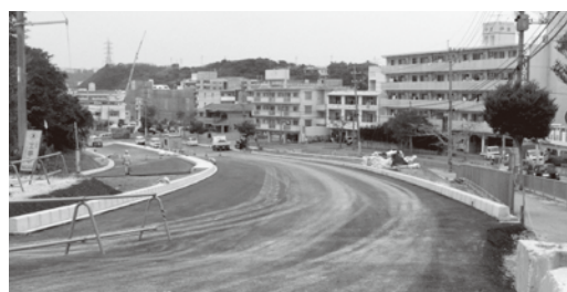
県道29号線拡幅工事
