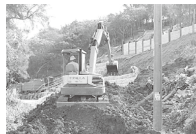
桃原・池田線の工事
