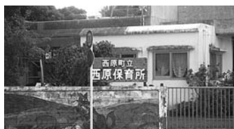
老朽化が進んだ西原保育所
