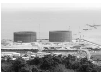
建設中の吉の浦発電所
