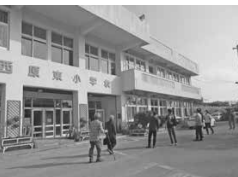
西原東小中学校の建て替え建設、進捗状況は？
