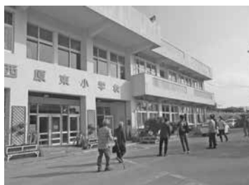
西原東小学校の建て替え建設、進捗状況は？
