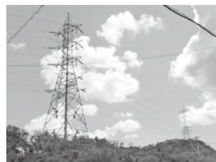
西原西地区の鉄塔移設について
