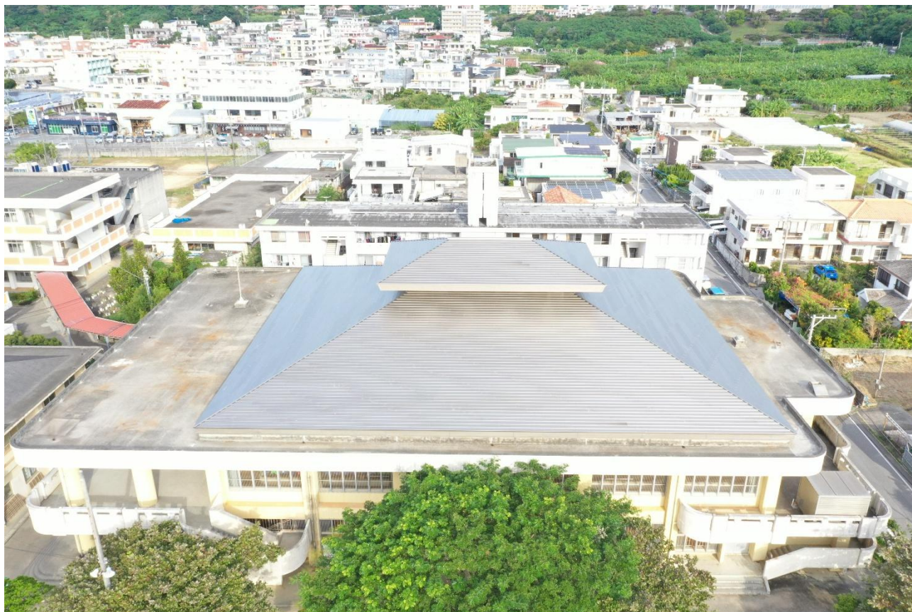
西原中学校体育館(屋根)
