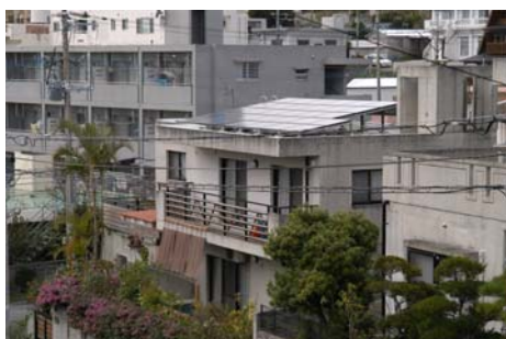
住宅の屋根に設置されている 太陽光パネル
