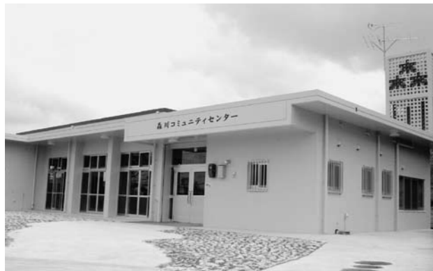
完成した森川コミュニティセンター全景
