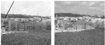
（11月19日撮影）※型枠工事が始まっています。 （11月13日撮影）
