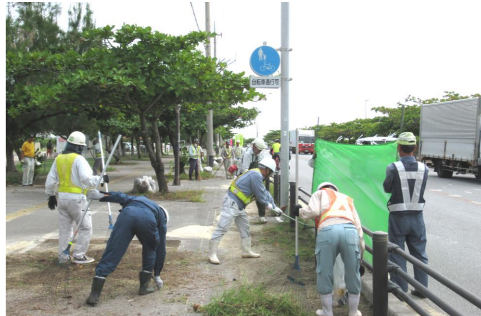
イルカ公園前周辺道 除草・清掃
