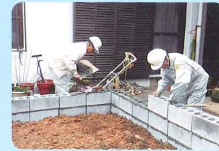
ブロック積み作業
