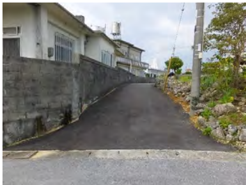
集落道路アスファルト舗装
