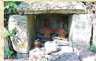
棚原比嘉家の土帝君(トゥーティーケー) 祠は、内法で開口50.5cm、奥行54cm、高さ50cmの石灰岩の3枚の切石で寄棟形に加工した屋根石を支えている。その内部には神体として夫婦をあしらった赤褐色を呈した陶製の男女一対の土帝君の神像が安置され、その前面には陶製の香炉が置かれています。
