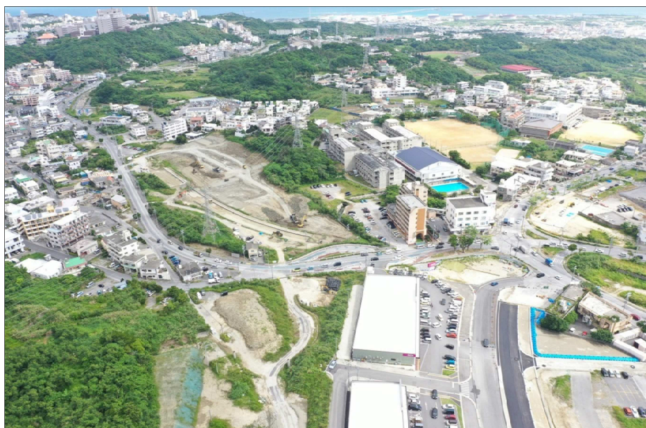
③坂田交差点から東側方向整備状況(R5.10月撮影)
