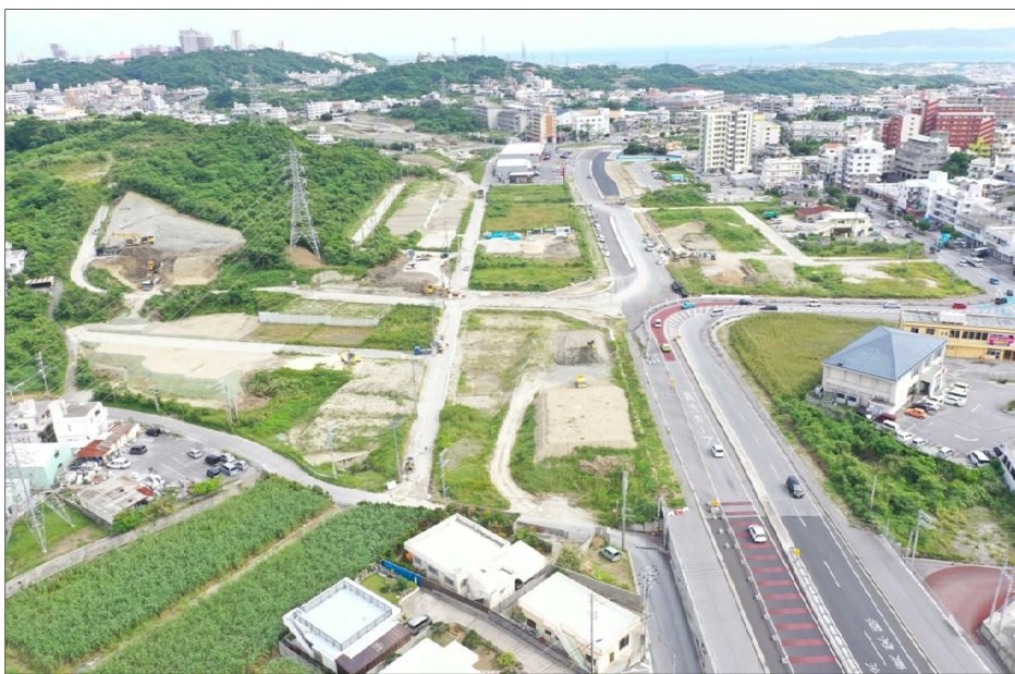
①浦添市側から東側方向整備状況(R5.10月撮影)
