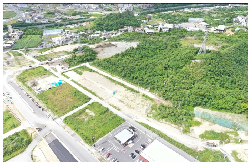
④坂田交差点側から徳佐方面整備状況(R5.10月撮影)
