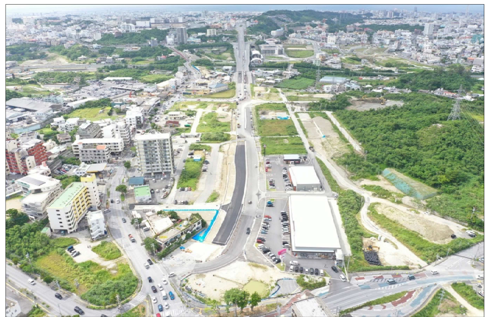
②坂田交差点側から西側方向整備状況(R5.10月撮影)
