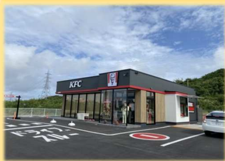
テナント棟②
