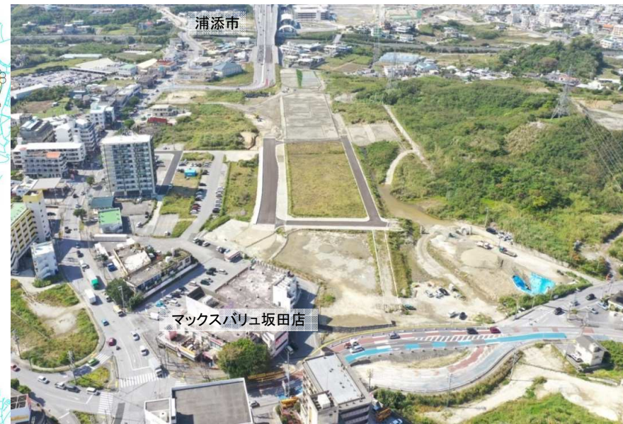
前田マンション側から西側方向整備状況
