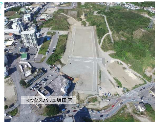
前田マンション側から西側方向整備状況
