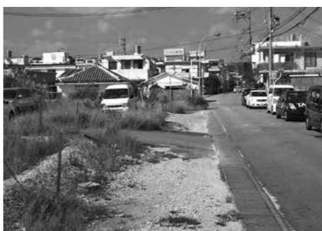
歩道部分がほとんどなく、塗装もかすれて見づらい(西原小学校付近)
