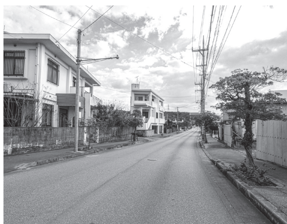
県道55号線冠水対策は！
