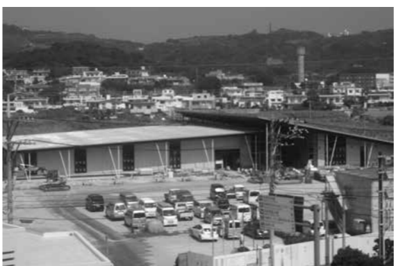
工事が進む西原さわふじマルシェ
