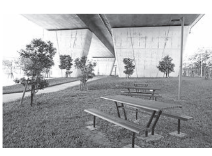
高架橋下の空閑地の利用例(南風原町地内)
