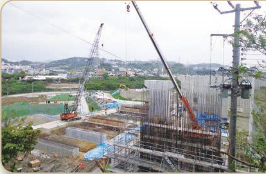
モノレール浦西駅建設予定地周辺を視察
