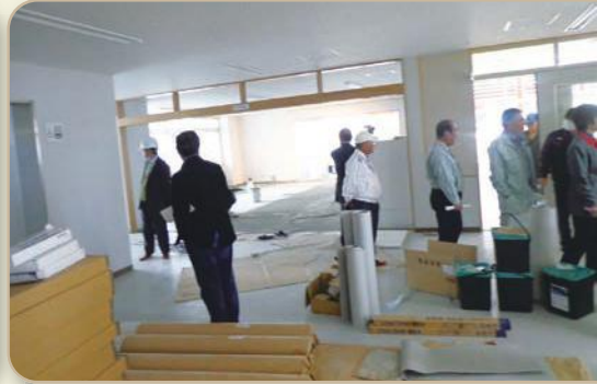
新增改築工事中の坂田小学校校舎を視察
