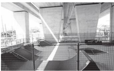
高架橋下を利用して遊具を設置（南風原町内）
