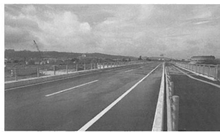
一部開通した国道329号線バイパス
