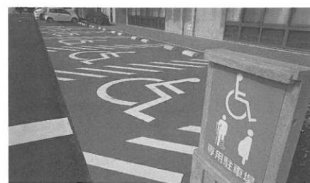
新庁舎の身障者用駐車場
