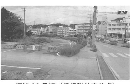
県道29号線(幡齒科前交差点)
