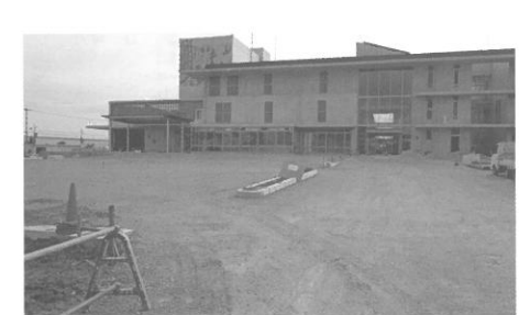
整備中の新庁舎駐車場（一部）
