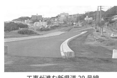
工事が進む新県道 29 号線
