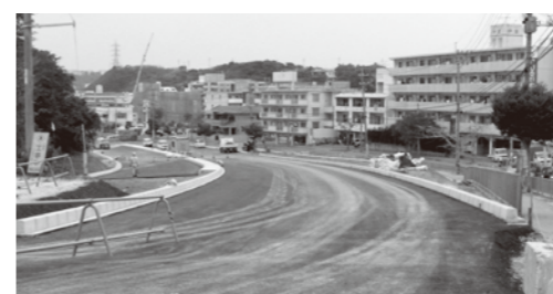
県道29号線拡幅工事
