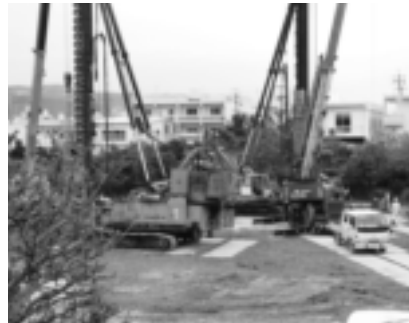
西原小学校改築工事
