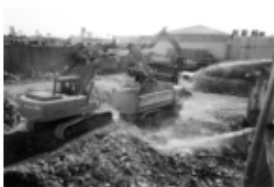
西原小学校校舎解体
