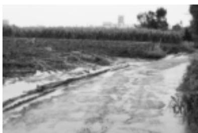
整備望まれる呉屋上屋部・小那覇線
