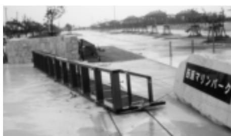
台風4号の被害
