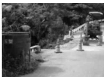
内間川沿の復旧工事
